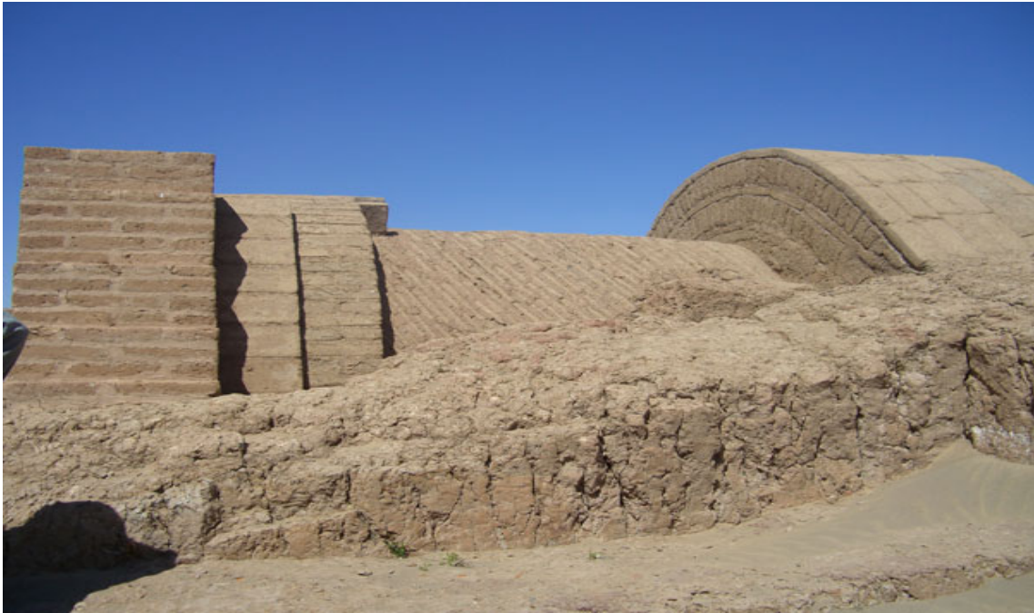
Dans Aïn Asil, le sanctuaire en briques du gouverneur Médou Néfer avec sa belle voûte nubienne.
