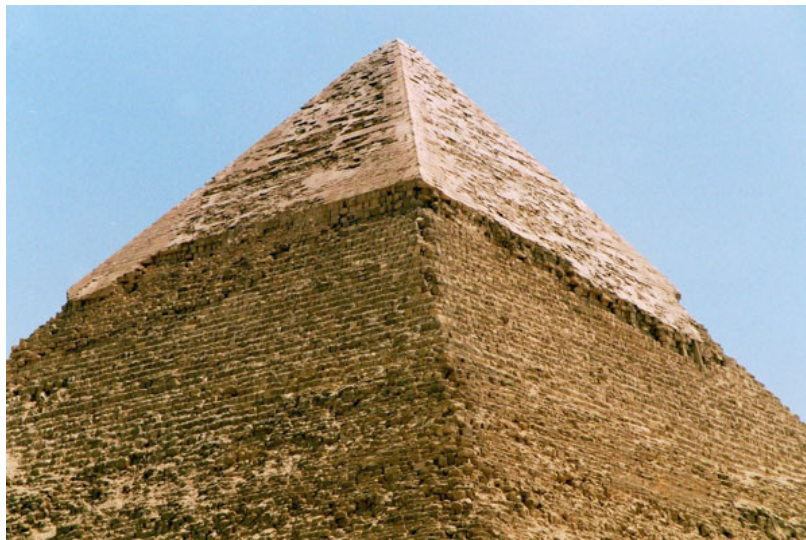
Le sommet de la pyramide de Khéphren conserve son revêtement de calcaire
