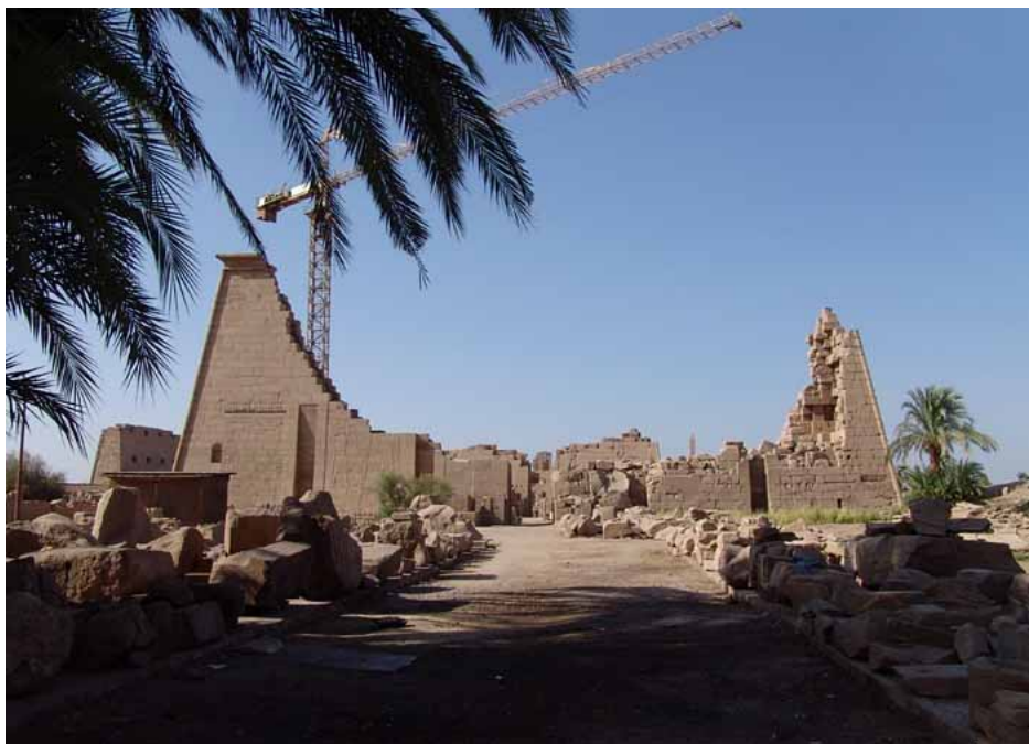
Face sud du IX e pylône en cours de remontage
